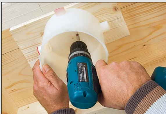
Anschrauben des Gehäuses.
